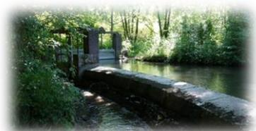
Suivez la descente de la Fure : au petit ponton, vous apercevrez une prise d'eau sur la droite (6). C'est le départ d'un long canal de plus de 1200m pour alimenter la microcentrale hydro-électrique de la Grande Poype et sa grande chute de 13m, toujours en fonctionnement depuis sa construction à la fin du XIX<sup>ème</sup> siècle.
